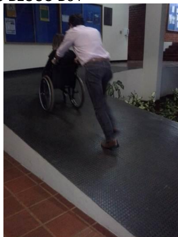
FIGURA 17 – RAMPA DE ACESSO BLOCO D34
