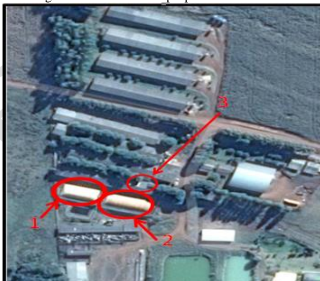
Figura 5: Vista aérea da propriedade Colombari
