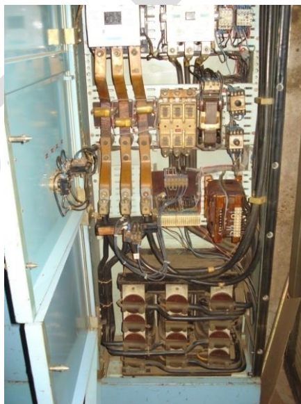
Figura 5: Painel da partida compensadora.
