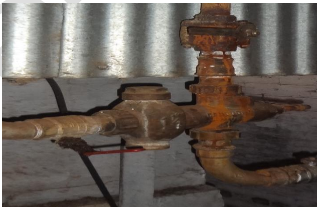
Figura 5 - Injetor a vapor
