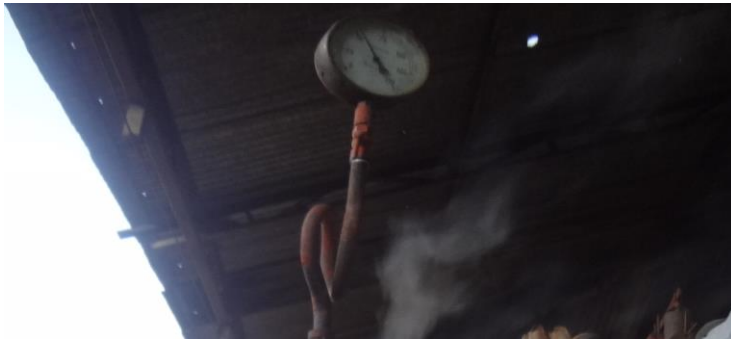
Figura 4 - Manômetro Caldeira
