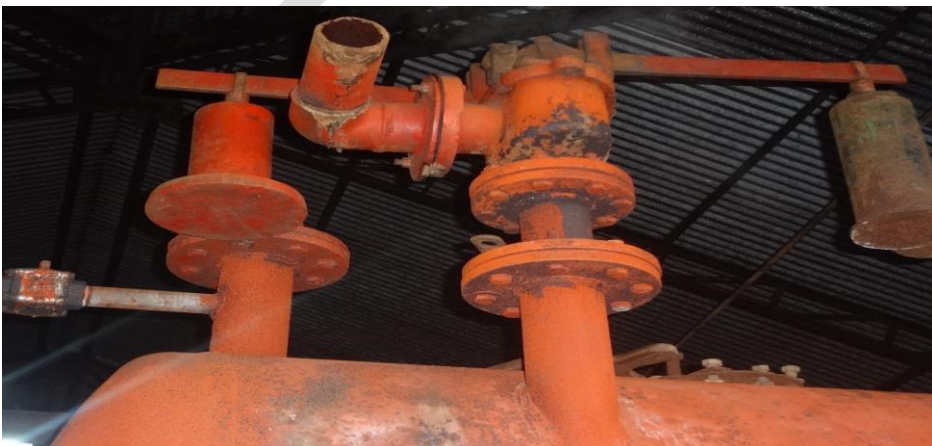
Figura 3 - Válvula de segurança de pressão
