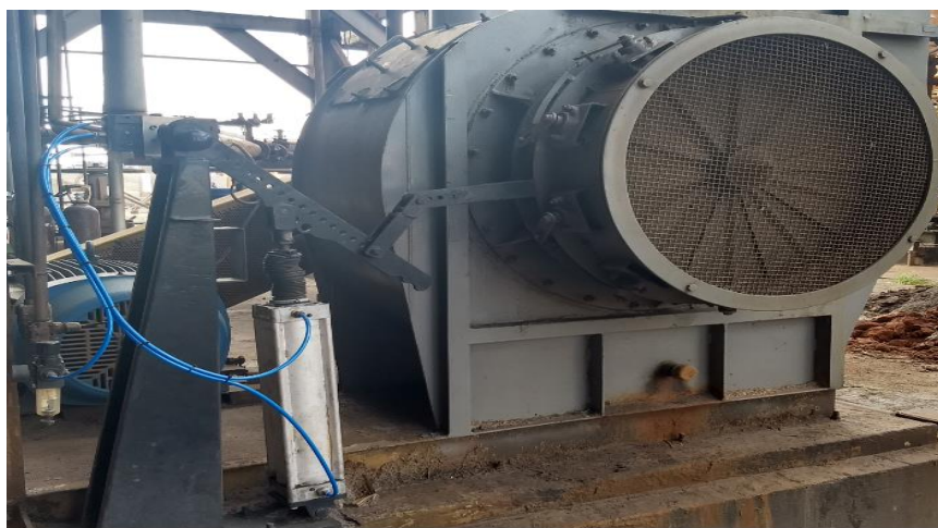
Figura 3: Damper ar primário tipo vortex
