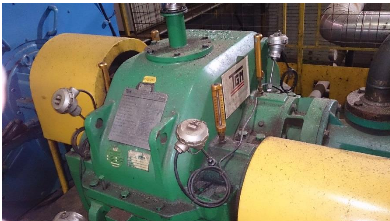
Figura 7: Turbina de acionamento com transmissores de temperatura.
