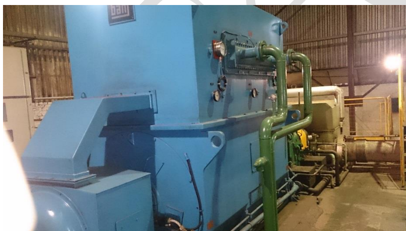
Figura 8: Gerador 5000KVA.
