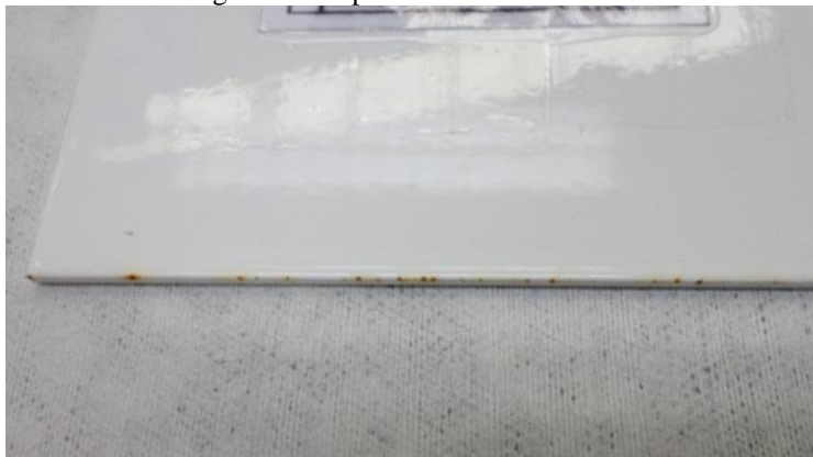
Figura 10 – Aparecimento da corrosão
