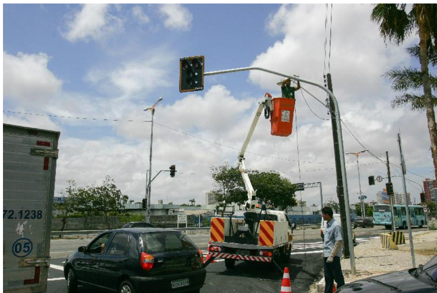
Figura 8 – Serviço executado em área de elevado trânsito
