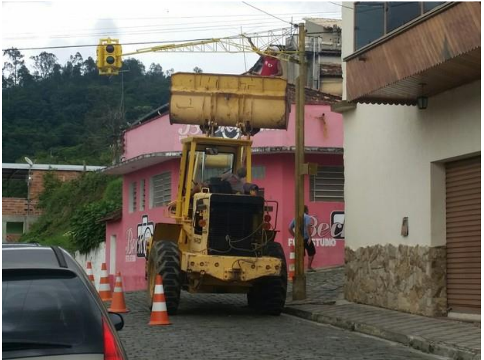
Figura 1 – Exemplo de atividade de manutenção improvisada
