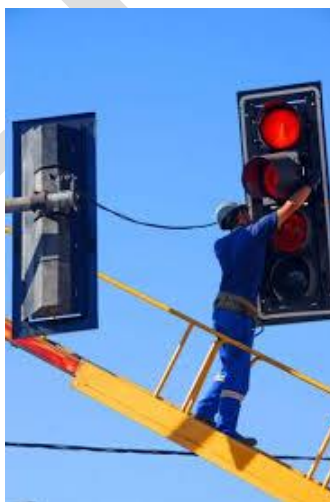
Figura 5 – Trabalhador em altura.
