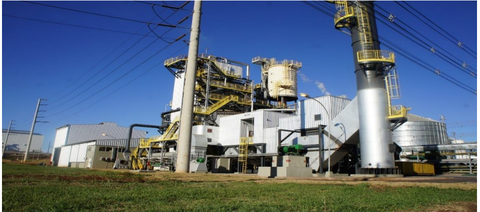
Figura1 - Caldeira água-tubular marca Burntech modelo Biocal 40 ton/h
