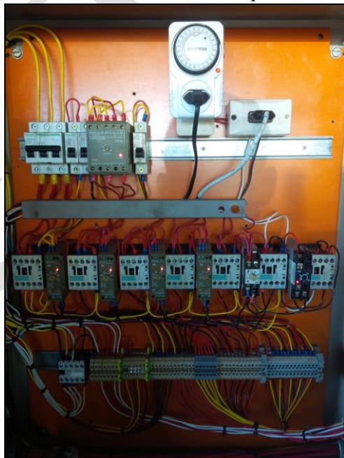
Figura 9 – Partida direta dos motores, sequenciada em cascata.
