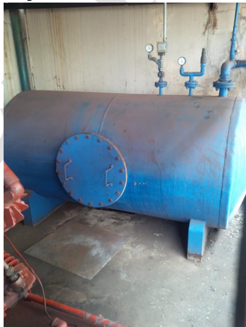
Figura 6 – Foto de um dos reservatórios.
