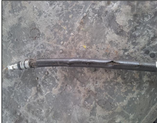
Figura 10 – Mangueira com vazamento.
