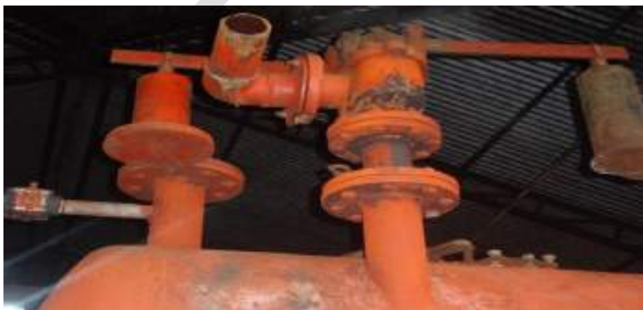
Figura 3 - Válvula de segurança de pressão
