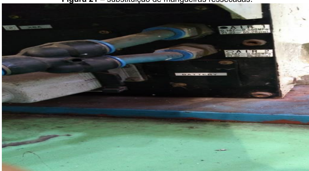
Figura 21 – substituição de mangueiras ressecadas.
