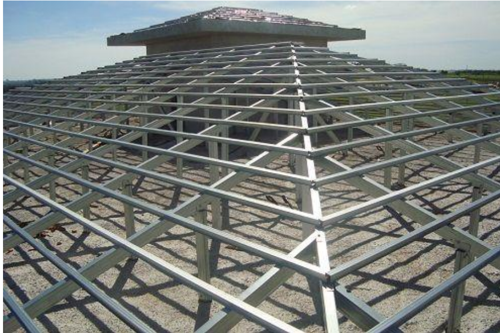
Figura 1: Estrutura de aço galvanizado
