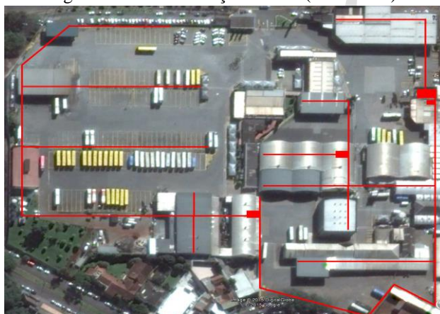
Figura 3 – Oficina Viação Garcia (vista aérea).
