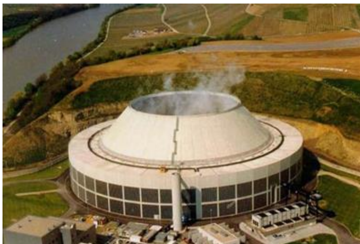
Figura 5 – Torre de resfriamento
