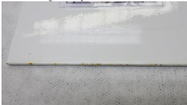
Figura 10 – Aparecimento da corrosão
