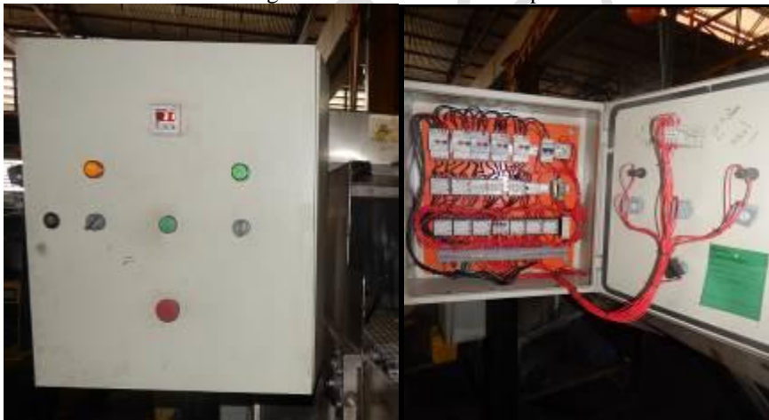
Figura 3 – Painel com os componentes
